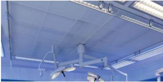
**Plenum:** Estanco (clase B según EN 1886) constituido mediante placas de acero dulce 15/10<sup>e</sup>, pintura epoxy blanca cocida al horno, RAL 9010, para ensamblar in-situ por tornillería
